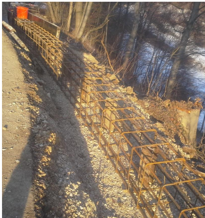
Slika 23 in 24: Izkop zaseka in zabijanje tirnic, postavitev armature
