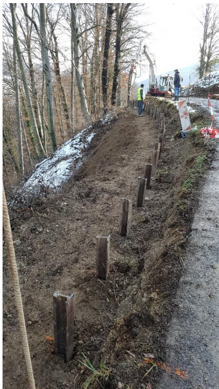
Slika 23 in 24: Izkop zaseka in zabijanje tirnic, postavitev armature
