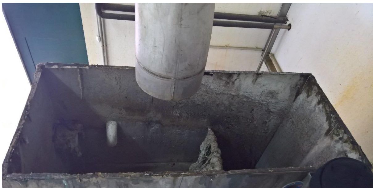
Zamenjava pokrova na vstopni komori kompaktne naprave
