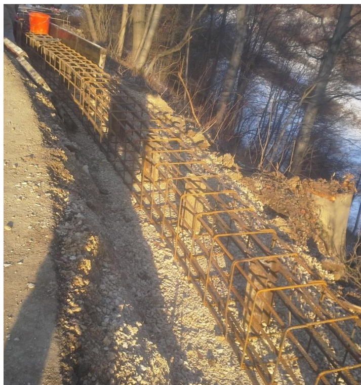
Slika 13 in 14: Izkop zaseka in zabitje tirnic, postavitev armature
