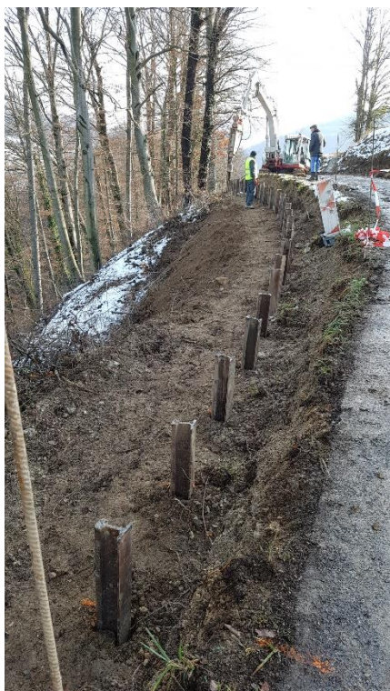
Slika 13 in 14: Izkop zaseka in zabitje tirnic, postavitev armature
